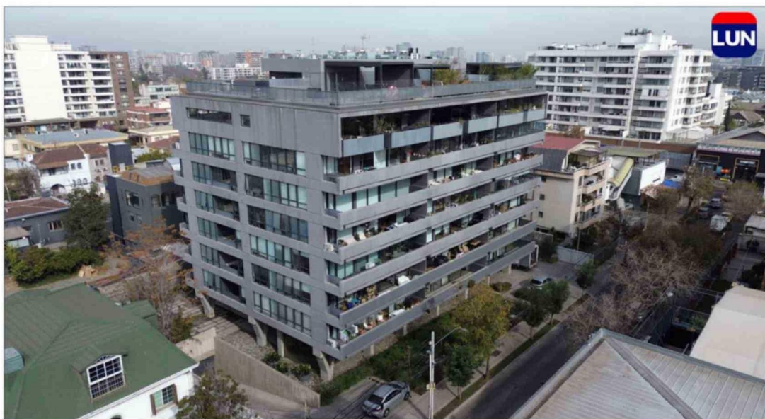
El edificio está emplazado en una calle de bajo flujo vehicular en Providencia.
