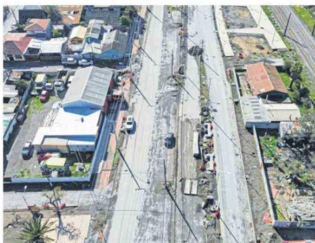
En el Eje Colón en Talcahuano las obras superan el 65% de avance.
