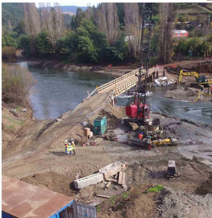
SE ESPERA QUE LA EJECUCIÓN DE LA OBRA SE DESARROLLE EN LOS PLAZOS ESTABLECIDOS, CON COORDINACIÓN PERMANENTE CON LOS MUNICIPIOS DE LUMACO Y GALVARINO Y LAS COMUNIDADES DEL SECTOR.
