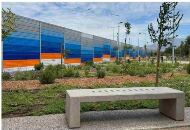
Barrera acústica absorbente Parque Serrano, Pudahuel.
