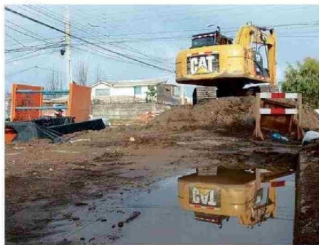
EN CALLE BROCKMAN SACOS DE ARENA RESGUARDARON LA OBRA.
