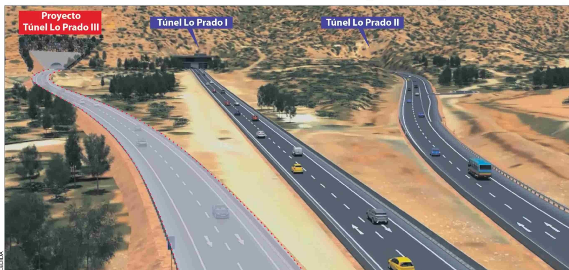
Ruta 68, vista hacia la costa: la calzada reversible contemplada en el proyecto, sería la del medio, que fue la primera que se construyó. La nueva calzada, a la izquierda en esta imagen, se usaría en sentido hacia Santiago.
