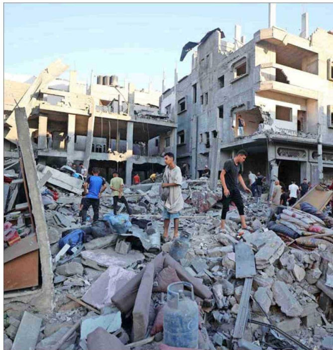
PALESTINOS inspeccionan un edificio dañado por un bombardeo israelí.
