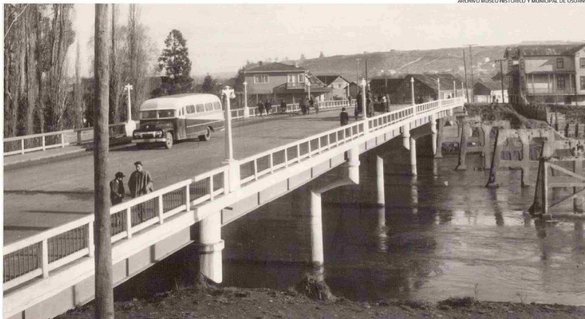
EL TERCER PUENTE SAN PEDRO FUE ABIERTO AL USO PEATONAL Y PARCIALMENTE AL TRÁNSITO EL SEGUNDO SEMESTRE DE 1959, TRAS CASI 10 AÑOS DE CONSTRUCCIÓN.
