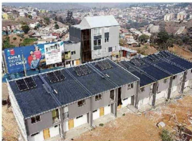
PRIVADA RECLAMA QUE EL PROYECTO FUE APROBADO POR EL SERVIU.
