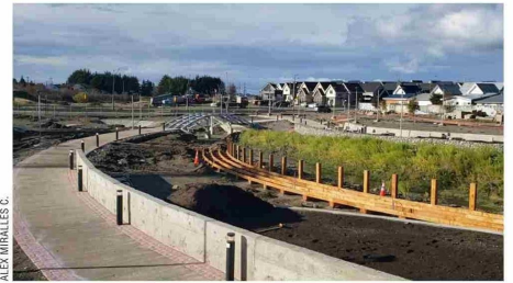
Así se desarrollan los trabajos de colectores de aguas lluvias del estero Llau Llau.
