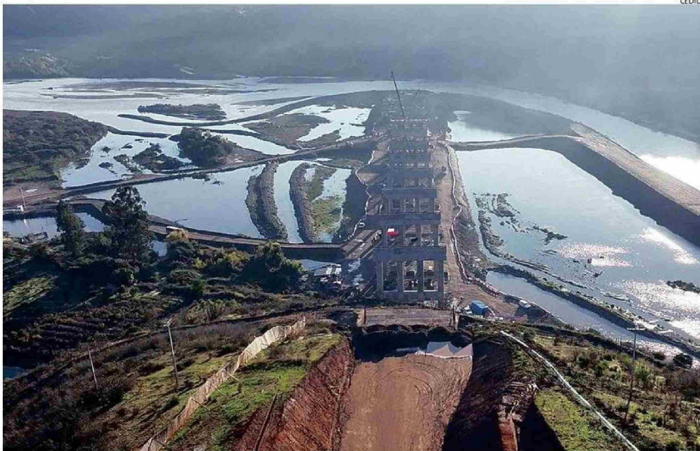
ESTA TARDE SE RETOMAN LOS TRABAJOS DE TRONADURAS PARA LA CONSTRUCCIÓN DE LA VARIANTE SAN JUAN.
