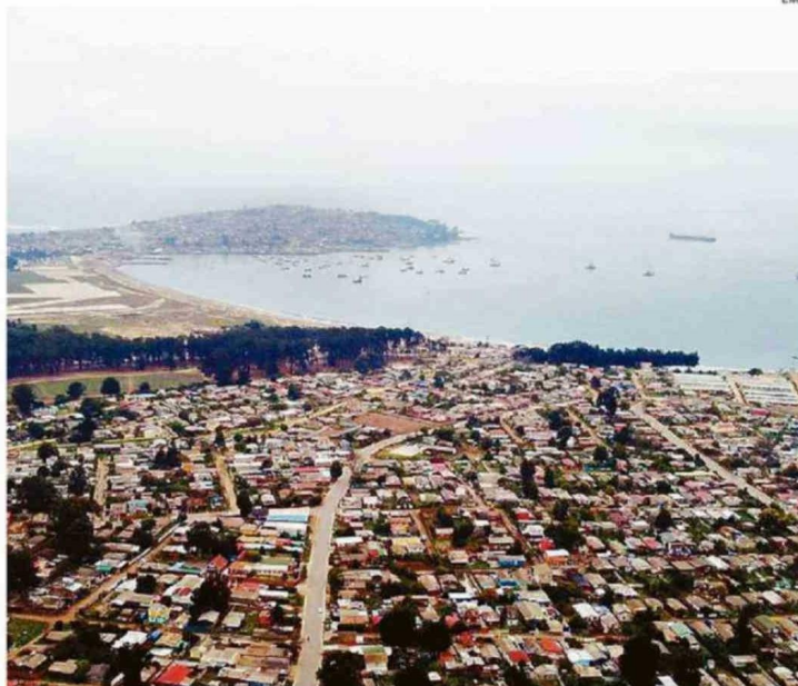
LOS EQUIPOS DE MONITOREO ESTUVIERON INSTALADOS EN LA ZONA DE QUINTERO Y PUCHUNCAVÍ.
