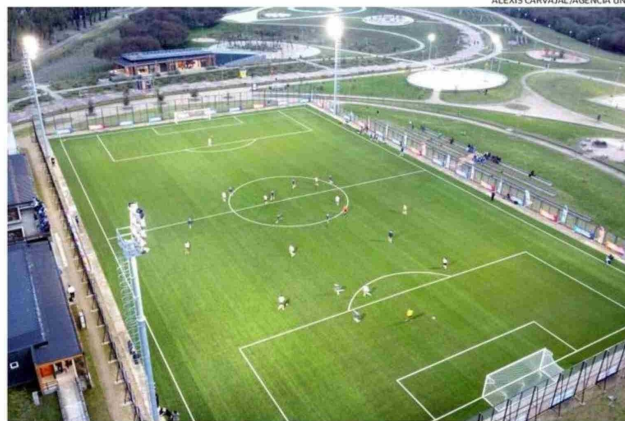
LA CANCHA AL INTERIOR DEL PARQUE HOTT FUE ENTREGADA AYER, AUNQUE EN EL RECINTO HAY OBRAS PENDIENTES.
