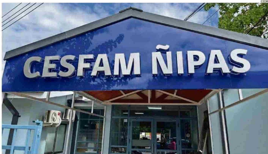
CESFAM DE ÑIPAS SUFRIÓ ATAQUES EN LOS ÚLTIMOS DÍAS, LOS QUE PROVOCARON DAÑOS POR 3 MILLONES DE PESOS.
