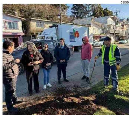
AYER COMENZARON LOS ARREGLOS EN EL CENTRO DE CALBUCO.
