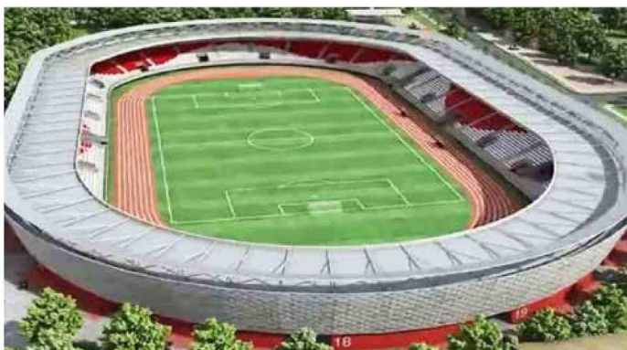
Recinto deportivo tiene un avance importante para ser usado prontamente.
