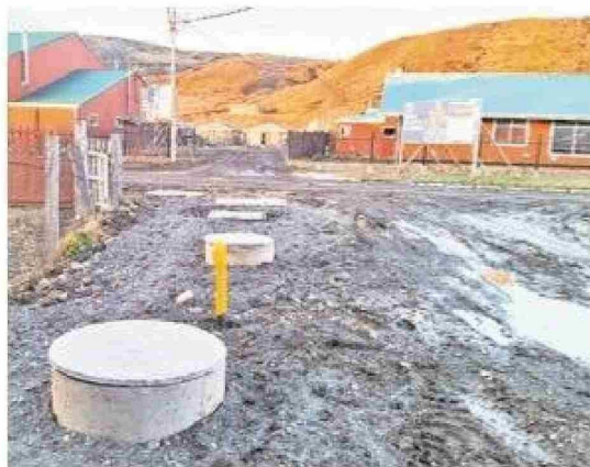
Las nuevas fosas sépticas en Villa Cameron.
