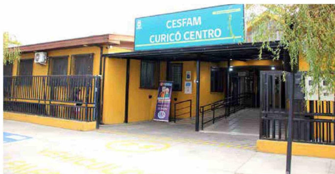
El Cesfam ubicado en calle Freire se ha hecho pequeño para el alto número de funcionarios y usuarios que concurren diariamente a concretar las distintas prestaciones disponibles.
