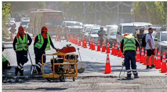
TACOS. —Recientes trabajos en la avenida Las Condes con Padre Hurtado causaron congestión durante esta semana.
