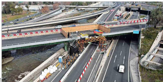
LABORES. —El puente Lo Saldes es clave para conectar los flujos vehiculares en el oriente de la capital.
