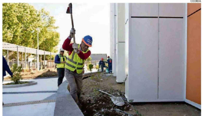
A FINES DEL PRESENTE AÑO, LA INFRAESTRUCTURA ESTARÁ OPERATIVA PARA LOS USUARIOS.
