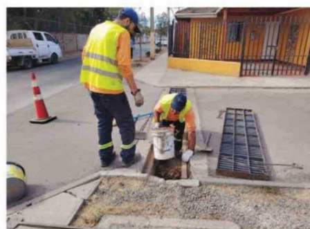
EN LAS POBLACIONES SE DESTAPAN CANALETAS SUBTERRÁNEAS.
