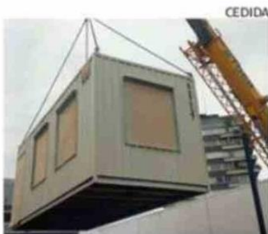
LAS NUEVAS AULAS MODULARES.
