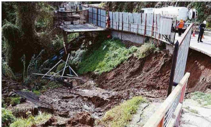
EL SOCAVÓN DERRUMBÓ UN PUEBLO QUE CONECTABA A TRES VIVIENDAS CON LA CALLE LAS ROCAS.
