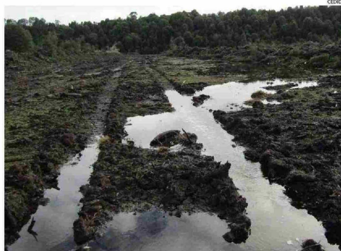
EN EL LUGAR SE HIZO ESCARPADO DEL LECHO Y RIBERAS, ASÍ COMO SE CONSTRUYÓ UN DRENAJE.
