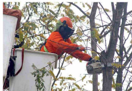
La presencia de arboleda y su ramificación sobre o en contacto con las líneas eléctricas son un peligro en contingencias climáticas ya que puede afectar el suministro.
