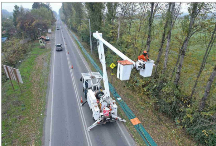
La presencia de arboleda y su ramificación sobre o en contacto con las líneas eléctricas son un peligro en contingencias climáticas ya que puede afectar el suministro.
