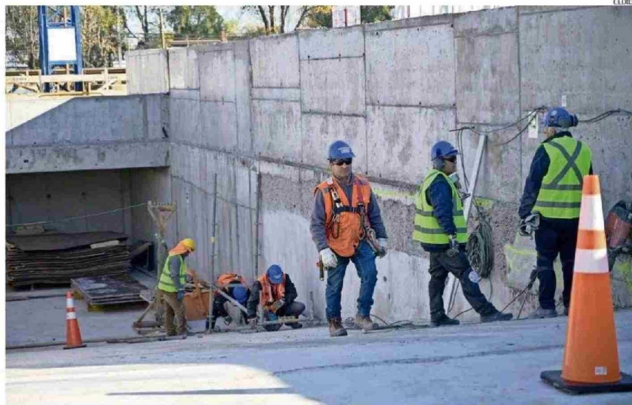
OBRAS DEL INSTITUTO TELETÓN EN ÑUBLE REGISTRAN UN 33% DE AVANCE. APERTURA ESTÁ PROYECTADA PARA EL PRIMER SEMESTRE DE 2027.
