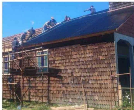
UNA DE LAS LABORES FUE EL RECAMBIO DE AMBOS LADOS DE LA TECHUMBRE POR FILTRACIONES Y PARA PREVENIR GOTERAS.
