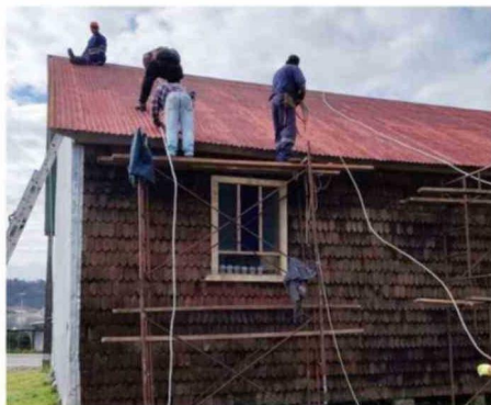
UNA DE LAS LABORES FUE EL RECAMBIO DE AMBOS LADOS DE LA TECHUMBRE POR FILTRACIONES Y PARA PREVENIR GOTERAS.
