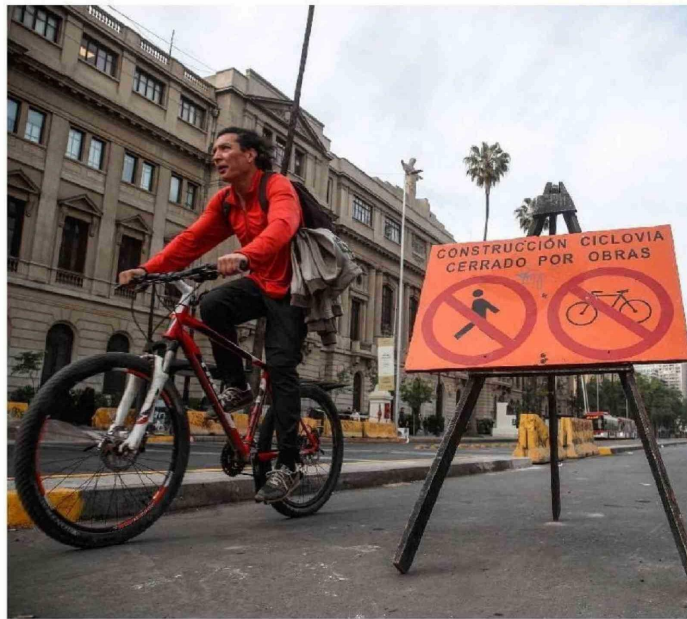
► Las obras de ciclovías en el proyecto Nueva Alameda están suspendidas.
