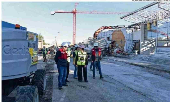
LA SEREMI PERALTA JUNTO A LOS REPRESENTANTES DEL MINISTERIO INSPECCIONARON LAS OBRAS
