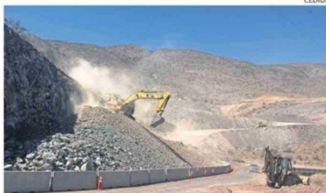
LO DE LA GRIETA ES UN PANORAMA QUE CON EL TIEMPO SE ACENTÚA.
