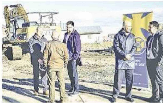
Las faenas para el centro de Puerto Williams comenzaron oficialmente el 13 de enero de este año con los primeros movimientos de tierra y se estima que la construcción finalice el 14 de diciembre de 2026.
