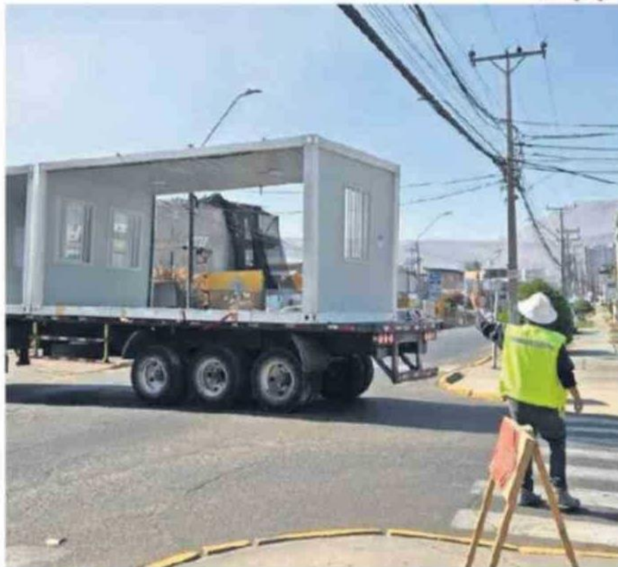
LA FAENA GENERARÁ CORTES DE TRÁNSITO EN AMBAS COMUNAS.
