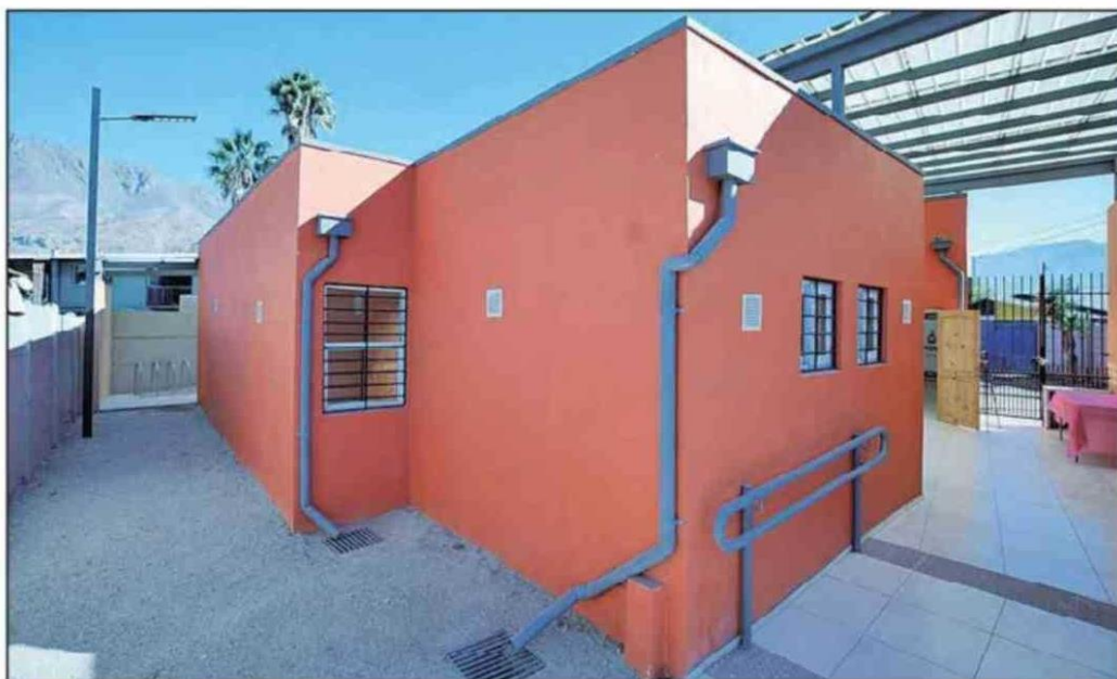
Sede cuenta con accesibilidad universal, cocina, baños, sala de reuniones, salón principal, mudador, cierre perimetral, zona de reciclaje y bicicletero.
