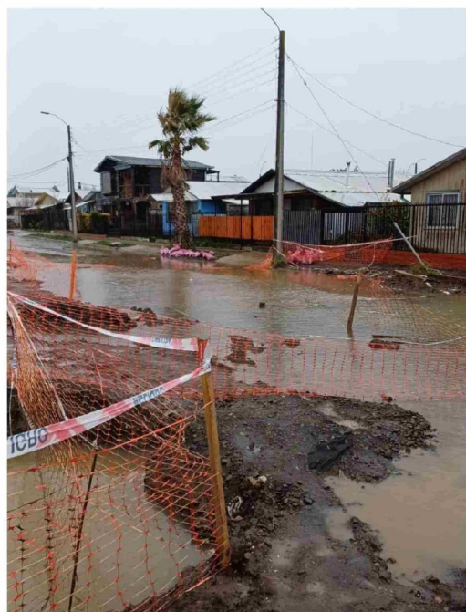
FAMILIAS SE HAN VISTO AFECTADAS por el desborde de aguas servidas tras varios días sin electricidad.
