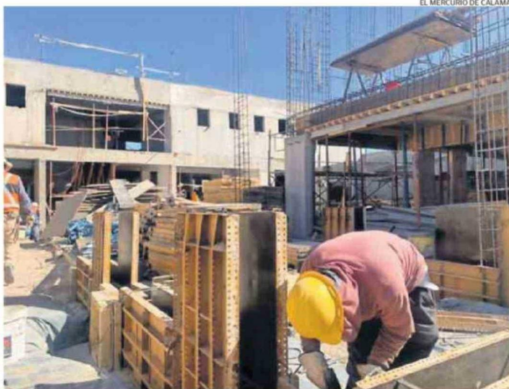
OBRA CIVILES DE LA REPOSICIÓN DEL HOGAR DE CRISTO DE CALAMA PODRÍAN ESTAR COMPLETAS EN JULIO.
