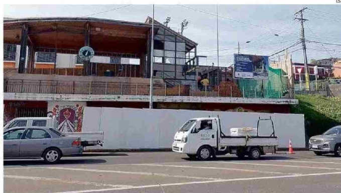
LOS TRABAJOS ESTÁN EN MARCHA EN LO QUE FUE LA OFICINA DE TURISMO.
