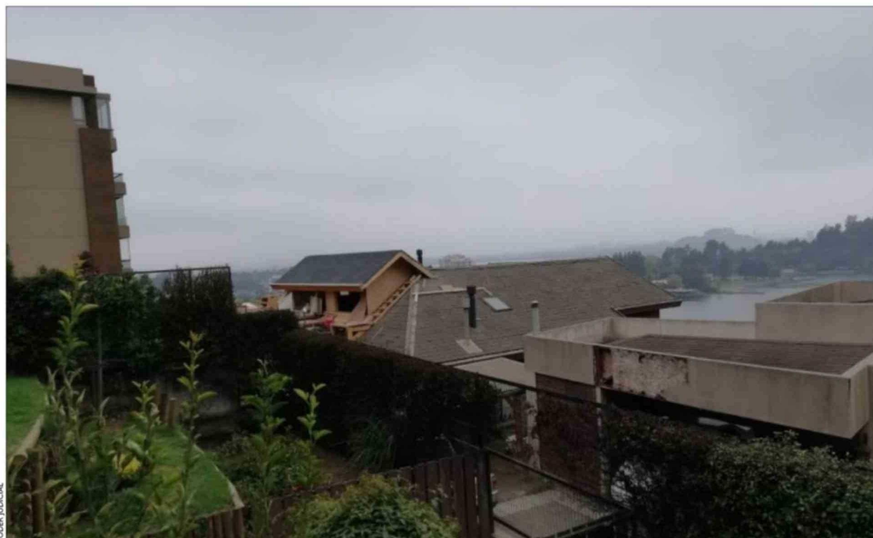
La mansarda elevó en 75 centímetros la altura de la casa, lo que cubre parcialmente la vista de la vecina a la laguna Llacolén.
