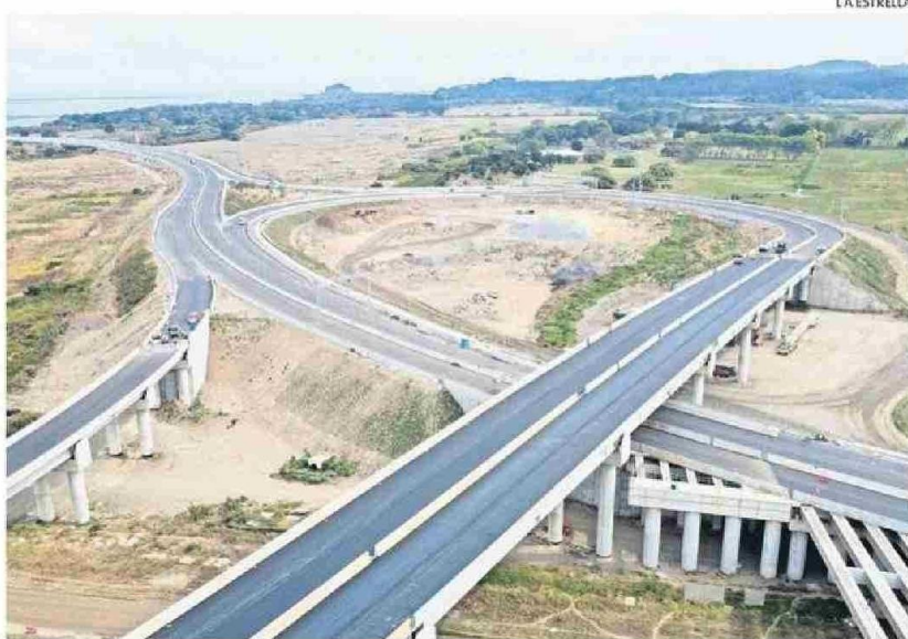
EL VIADUCTO UNE HUALPÉN Y SAN PEDRO DE LA PAZ, Y BUSCA DESCONGESTIONAR LA RUTA 160.
