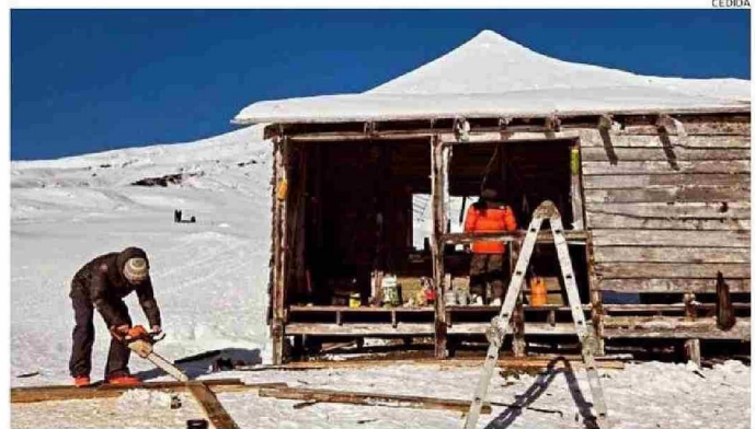
EL HISTÓRICO REFUGIO LA PICADA SE ESTÁ RECONSTRUYENDO, PESE A LA COMPLEJIDAD DEL CLIMA.
