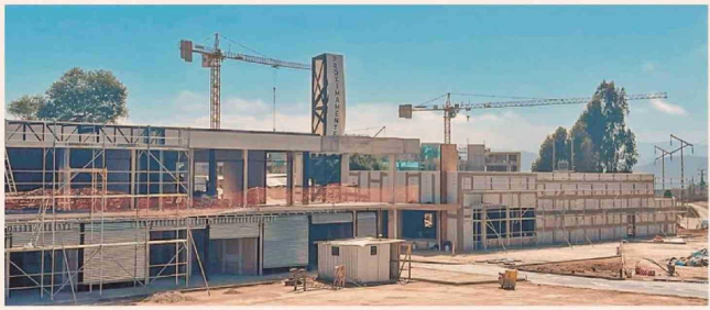
Con una inversión de US$ 5,5 millones, el centro comercial Marbella Alcazaba registra un avance de 80% y su apertura se proyecta para el segundo semestre.
