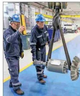
El motor eléctrico de una bomba de incendio de la fragata "Lynch" es otro fruto del centro.
