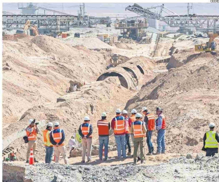
LAS INUNDACIONES SEPULTARON LAS CORREAS TRANSPORTADORAS DE MINERA EL ABRA EN FEBRERO DE 2019. CEDIDA
