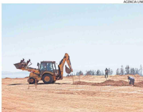
EN PUNTA DE PARRA ESTÁN CONSTRUYENDO ESCUELA MODULAR.
