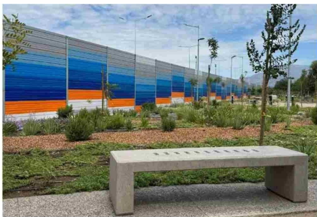
Barrera acústica absorbente Parque Serrano, Pudahuel.
