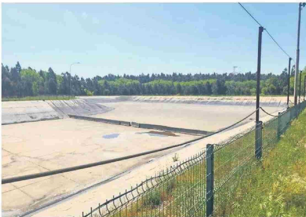
SMA realizó una fiscalización donde pudo constatar que la celulosa desvió residuos industriales líquidos.
