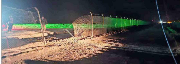
Los delincuentes entran a las instalaciones de las empresas en lugares remotos y roban cables de cobre, paneles solares, camionetas, combustibles y hasta cercos.
