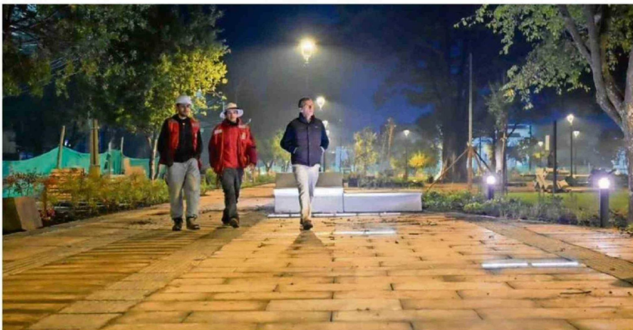
OBRAS DE RENOVACIÓN REGISTRAN UN 90% DE AVANCE EN LA PLAZA.
