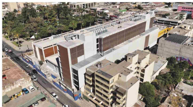
Un 90% de avance presente el edificio consistorial de Ovalle.
