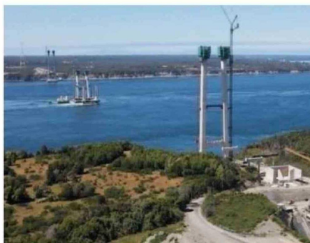
EN EL CANAL QUE SEPARA CHILOÉ DEL CONTINENTE SE LEVANTAN LAS PILAS QUE SERÁN EL SOPORTE DEL PUENTE COLGANTE MÁS GRANDE DE LATINOAMÉRICA.
